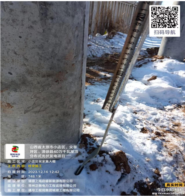
侯家寨大棚柱上变接地扁铁镀锌层厚度及搭接长度不符合设计、规范要求
