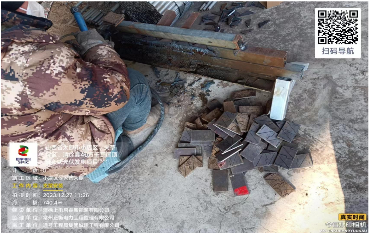
立柱与底板加劲板使用废旧材料加工制作, 不符合设计规范要求
