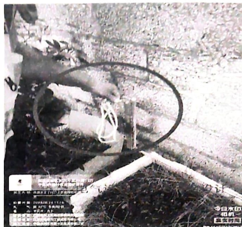
电气设备接地不符合设计要求
