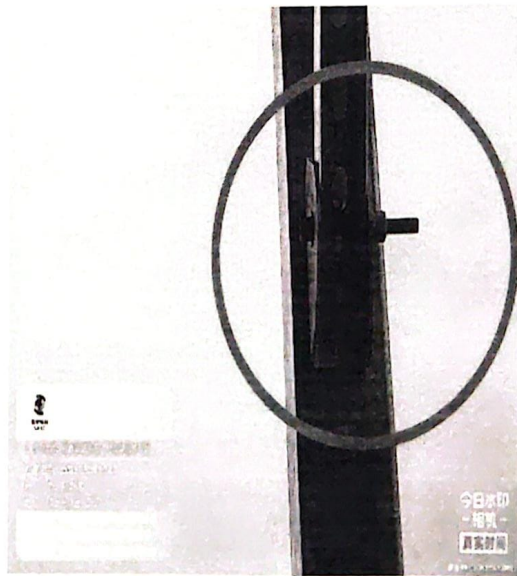
支架螺栓错装
