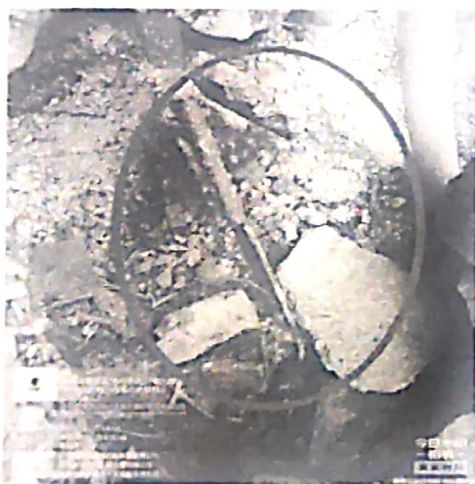
接地扁铁与接地极搭接面不够
