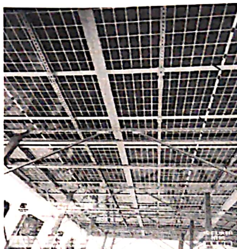
中水槽通长未固定
