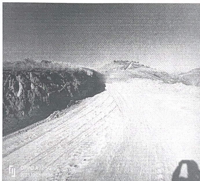
转弯处未设置反光镜存在安全隐患(图2)
