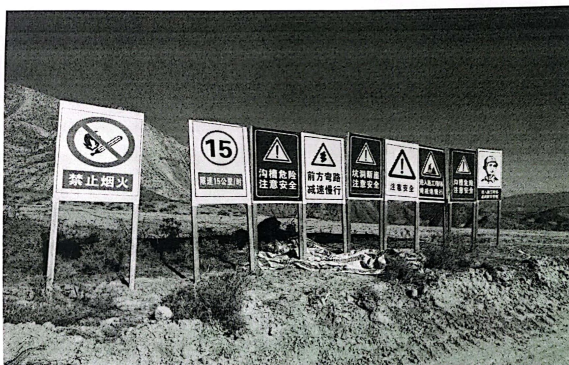
永靖县 330KV 升压站土方开挖施工现场（图 2）
