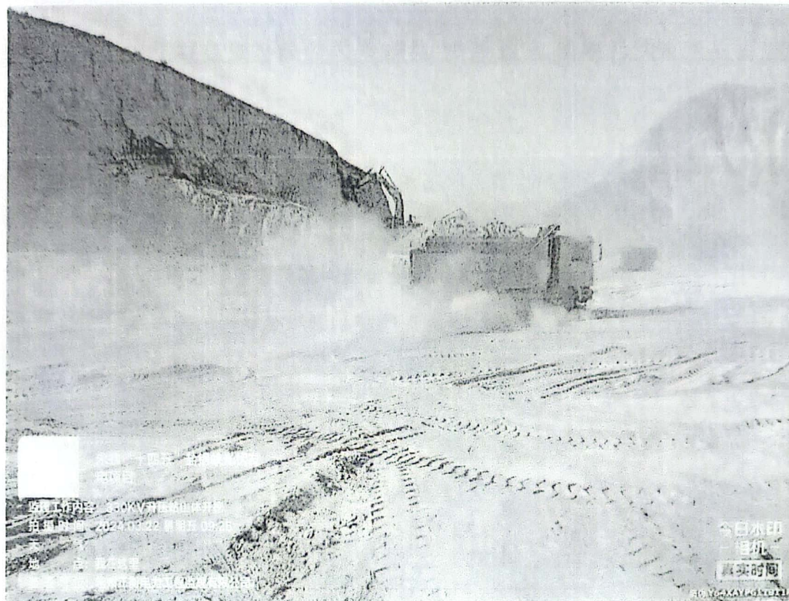
永靖330KV升压站山体开挖施工现场 (图1)
