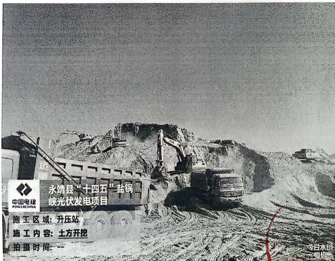
永靖县 330KV 升压站土方开挖施工现场 (图 1)
