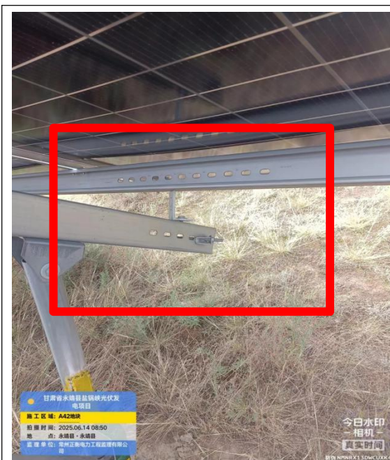
支架安装严重不符合图纸要求
