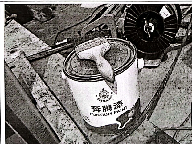
防腐、防锈油漆不符合要求
