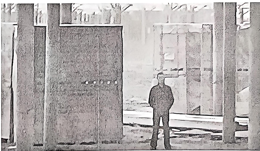
进入施工现场未佩戴安全帽
