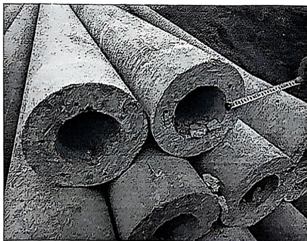
附件三：壁厚不达标的管桩厂家已整改换桩
