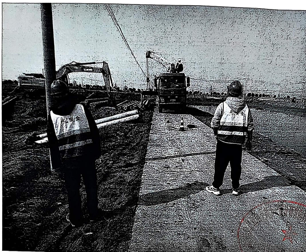
附件一：卸桩已设置警示锥桶，并有安全人员进行旁站监护
