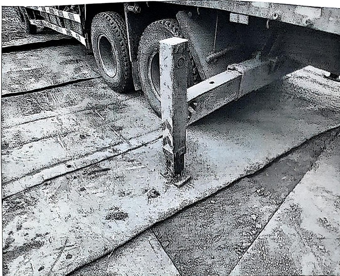
附件一：已安排人员进行卸桩安全旁站，并对支腿铺垫枕木钢板
