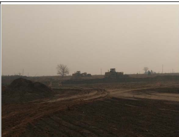
二次平整场地
