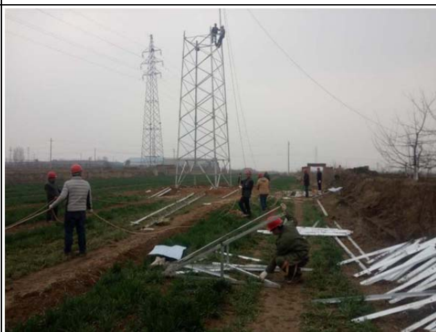
外线组装铁塔
