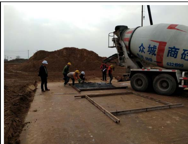
电控楼独立基础垫层
