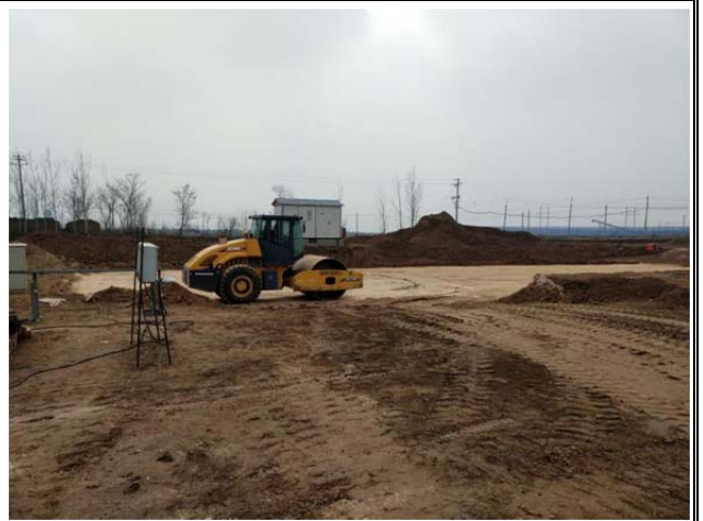
电控楼灰土垫层压实
