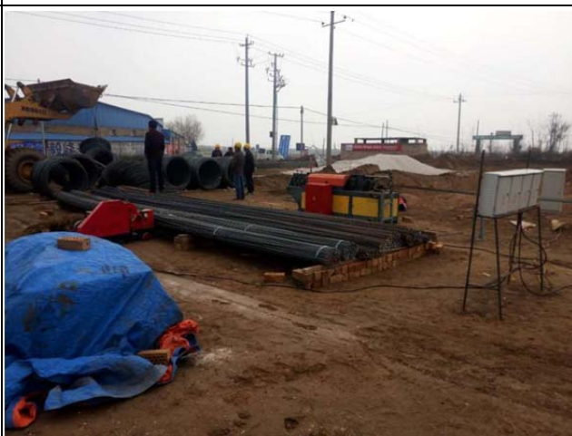
电控楼钢筋加工
