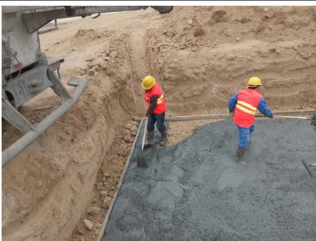
箱逆变基础垫层施工
