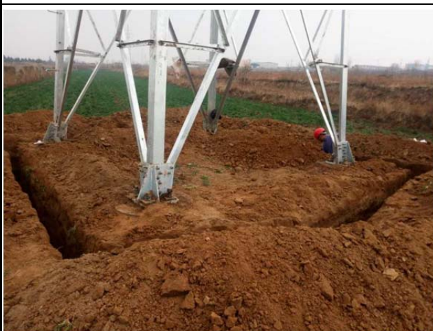
外线铁塔接地施工
