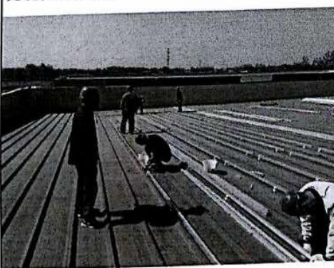
现场施工安全帽佩戴不规范
