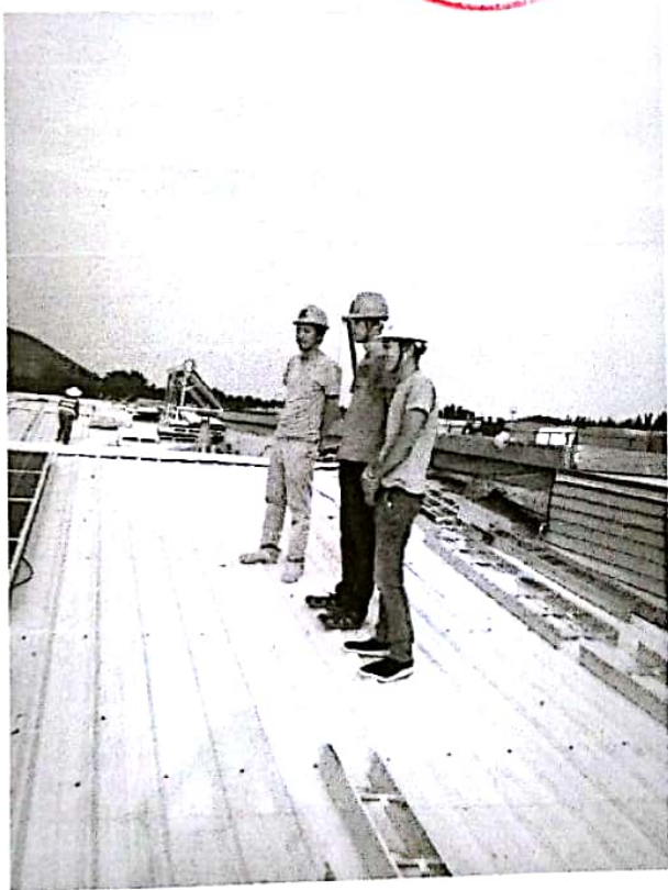
附 1：业主、监理及施工三方对现场进行安全检查
