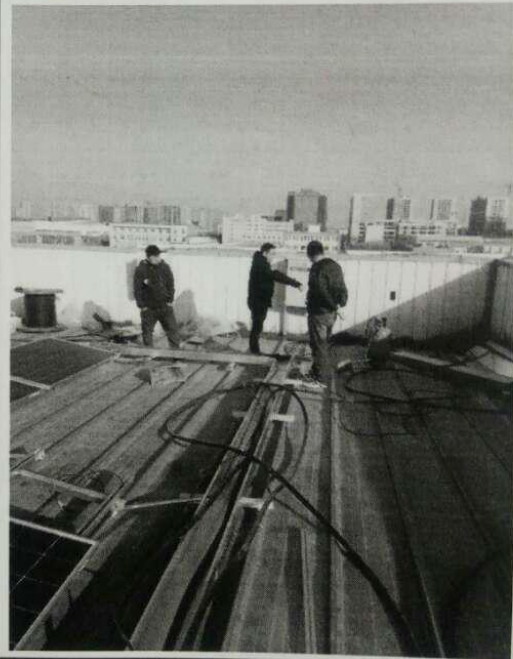
逆变器接线屋面安全文明施工检查
