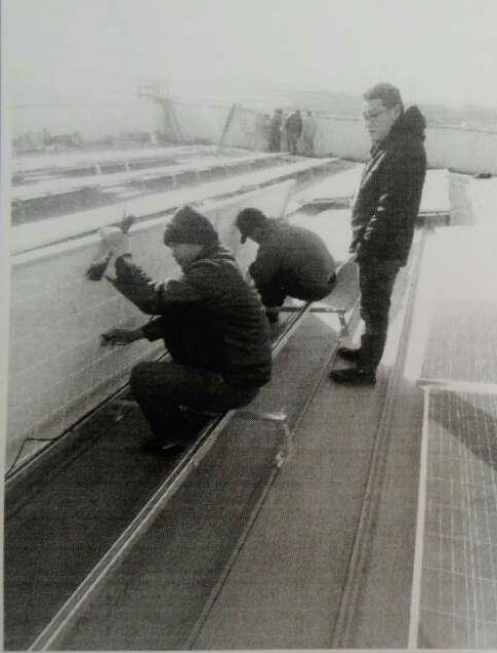
组件串线及绑扎检查
