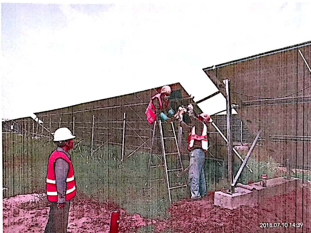
新增光伏组串接地扁铁焊接
