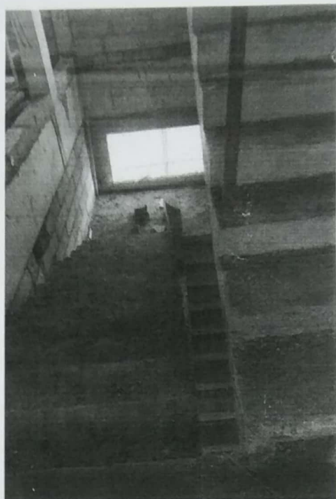
楼梯需要做好临边防护
