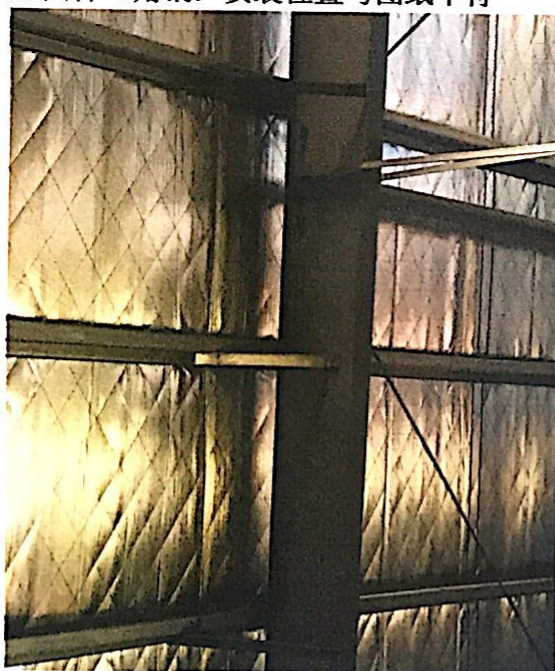
加固件（角钢）安装位置与图纸不符
