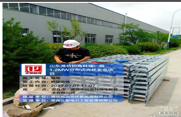
桥架检查检查
