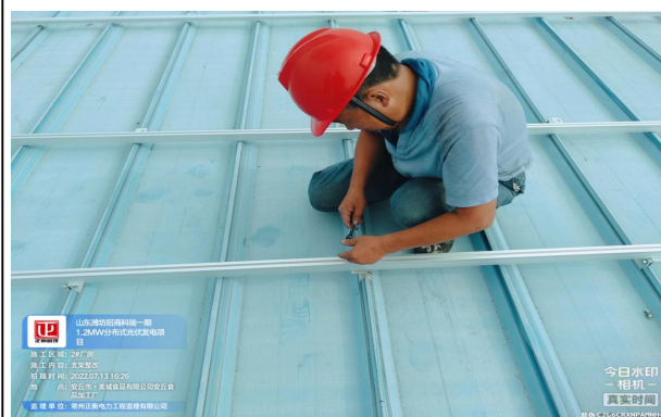
2#厂房支架整改消缺
