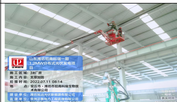
3#厂房斜撑加固
