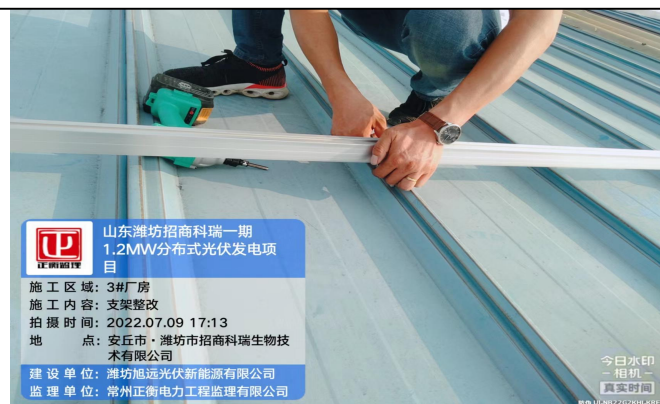
3#厂房整改消缺
