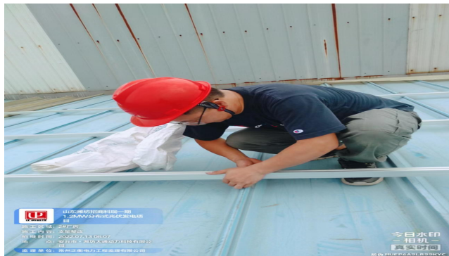
2#厂房支架整改
