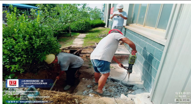
3#厂房电缆沟开挖
