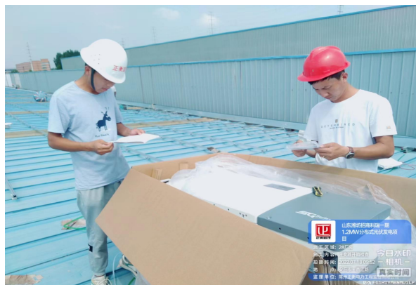
逆变器开箱检查
