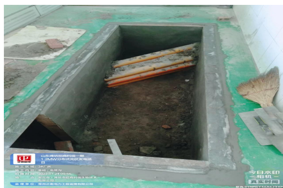
2#厂房桥架接地防腐
