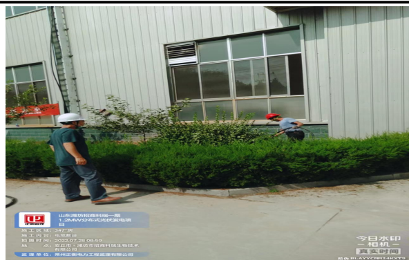
电缆敷设检查
