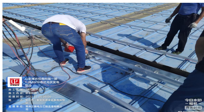
接地桥架防腐
