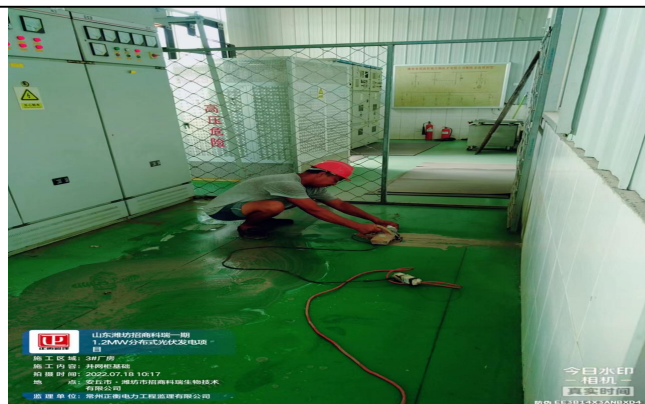
3#厂房配电室基础施工
