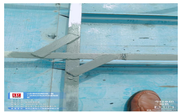
接地防腐检查
