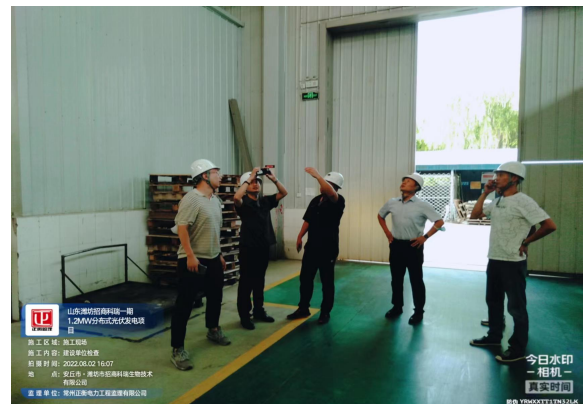
业主质量安全检查
