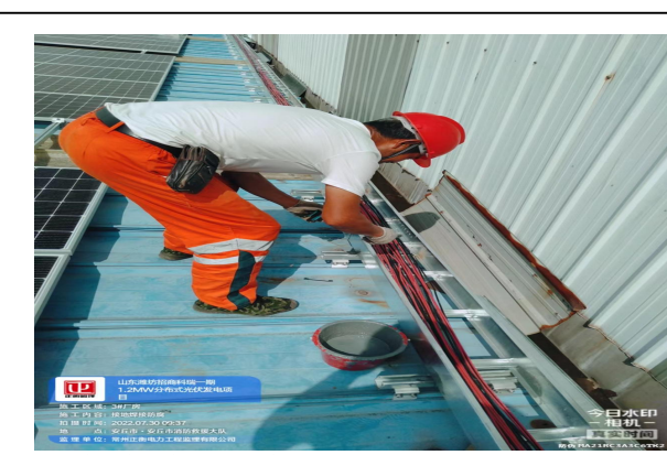
3#厂房桥架接地防腐
