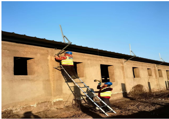
山西省太原市晋源区17万千瓦分布式光伏发电项目 施工区域：襄大养殖场 施工内容：导轨安装 建设单位：山西上电启睿新能源有限公司 监理单位：常州正衡电力工程监理有限公司
