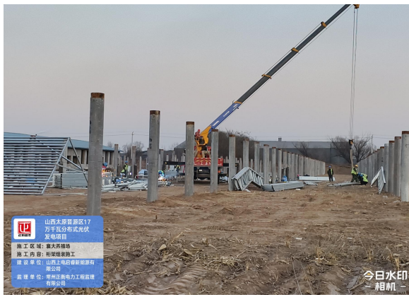
山西省太原市晋源区17万千瓦分布式光伏发电项目 施工区域：襄大养殖场 施工内容：构架安装 建设单位：山西上电启睿新能源有限公司 监理单位：常州正衡电力工程监理有限公司
