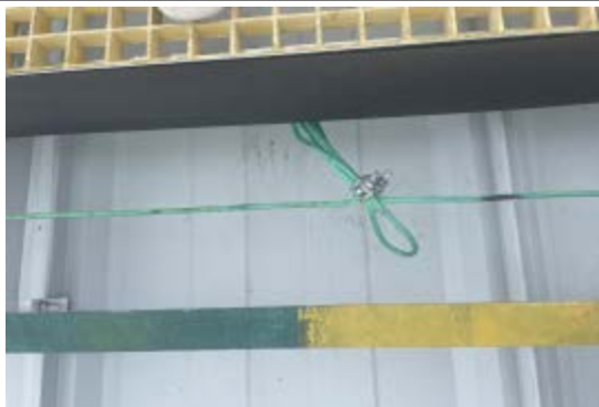
整改前：屋面安全生命绳连接不符合要求
