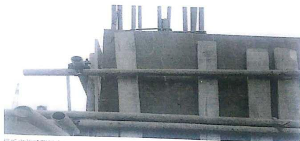
模板安装缝隙过大
