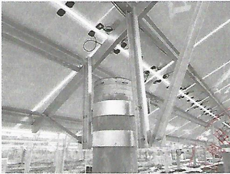
防腐漆脱落
