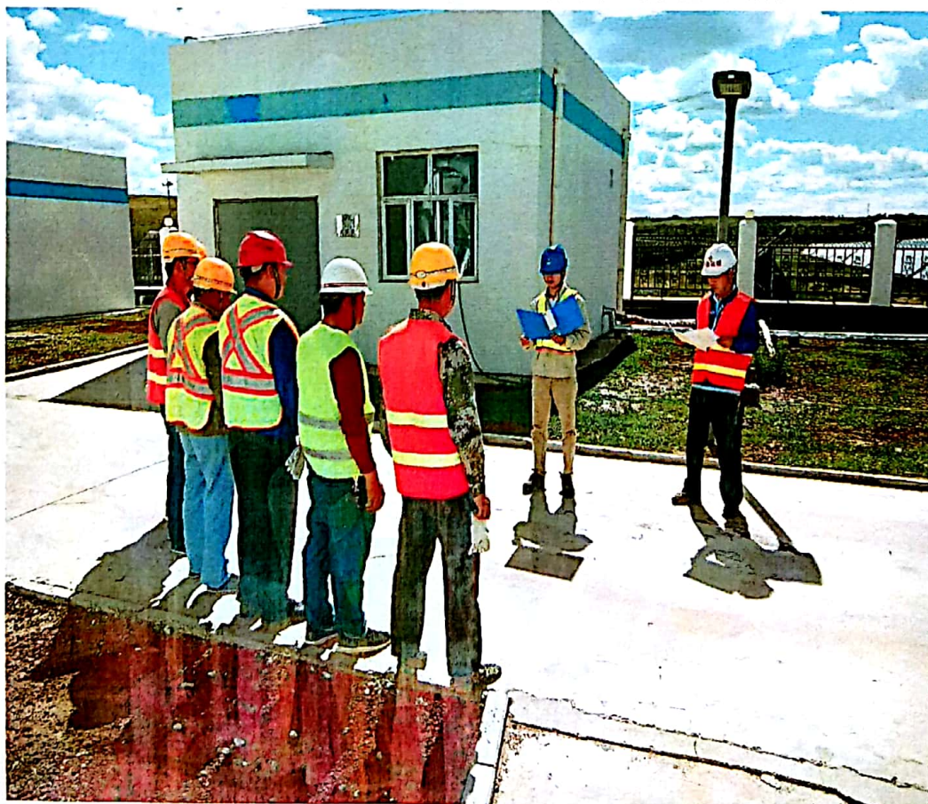
施工现场问题整改安全、技术交底
