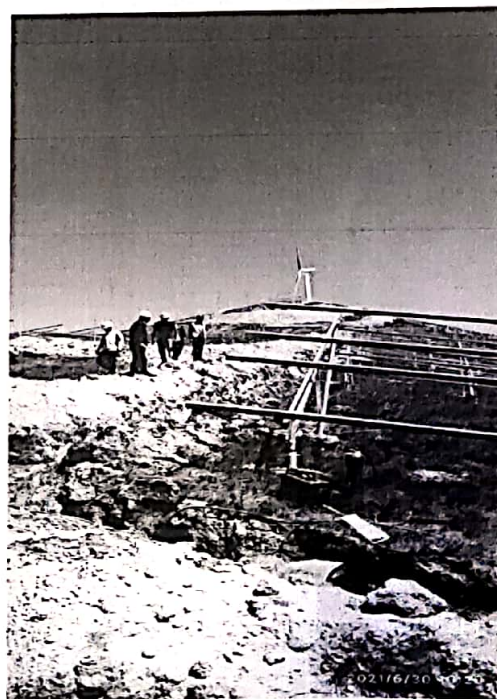
检查光伏区接地环网焊接
