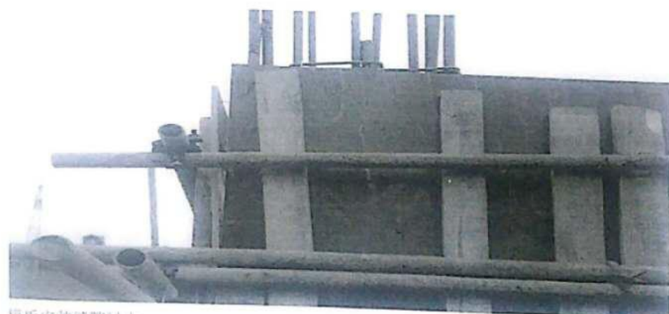
模板安装缝隙过大
