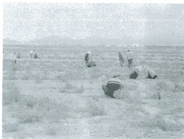
施工现场工人未佩带安全帽
