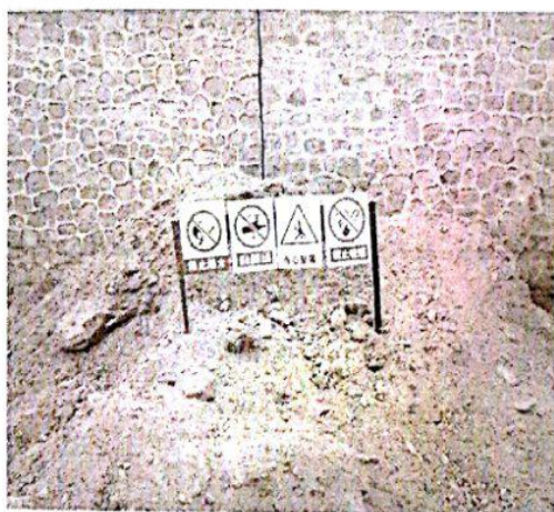
现场施工地点设置安全警示标语
