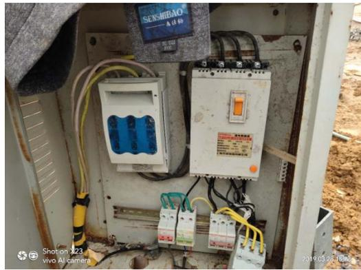
临时用电线路私拉乱接、配电箱无锁、无接地
