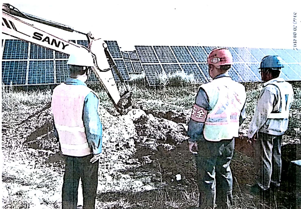
新增光伏组串镀锌扁铁接地与原接地主网连接接地沟回填监理旁站
