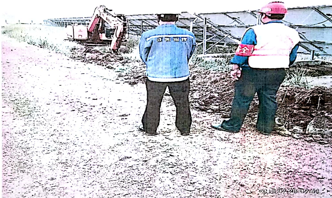
新增光伏组串镀锌扁铁接地与原接地主网连接接地沟开挖监理旁站
