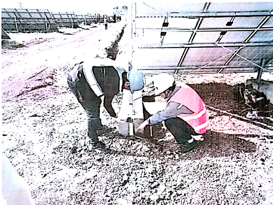
监理检查新增光伏组串接地下引处黄绿漆涂刷
