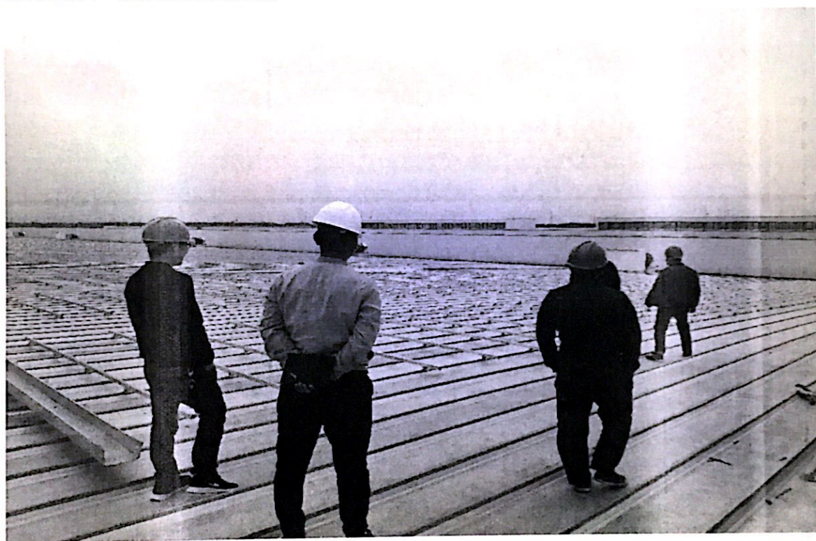
业主方现场负责人、三家施工单位现场负责人与我监理项目部人员共同检查曲美厂房屋面光伏支架、电缆桥架安装情况
