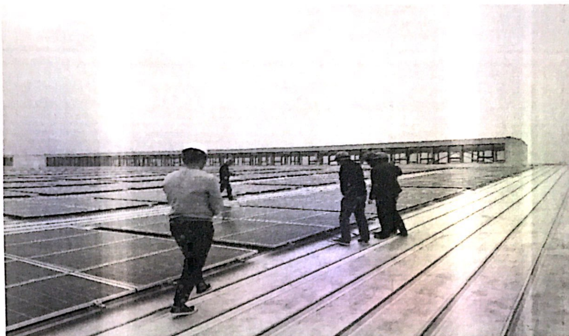
业主方现场负责人、三家施工单位现场负责人与我监理项目部人员共同检查曲美厂房屋面光伏组件、电缆桥架安装情况
