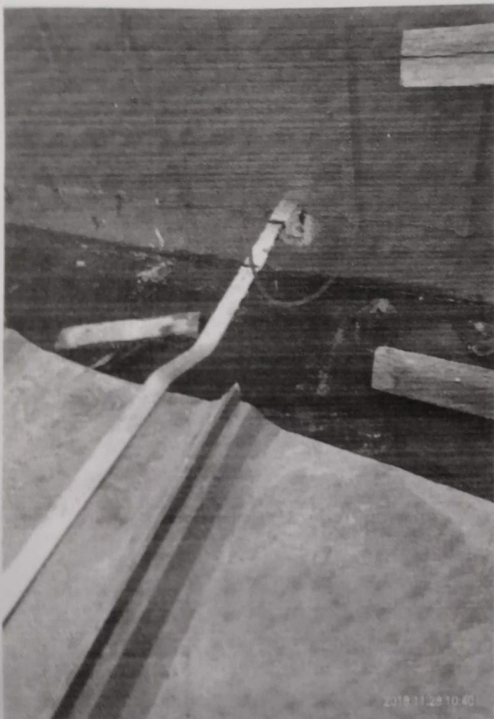
接地镀锌扁铁与厂房接地主网搭接长度不符合设计要求
