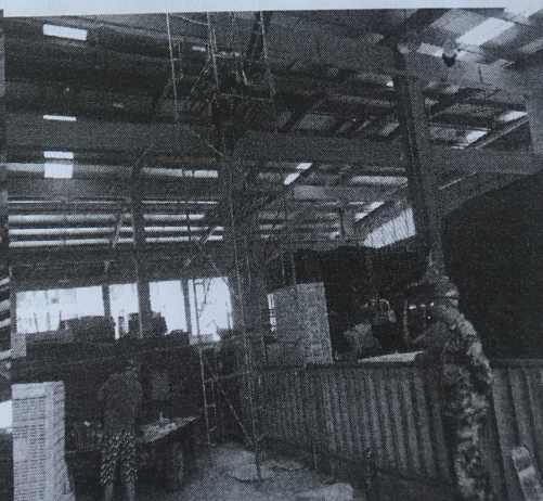
施工现场监护
