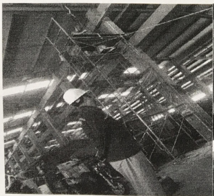
监理现场检查
