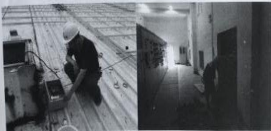
临时用电检查
