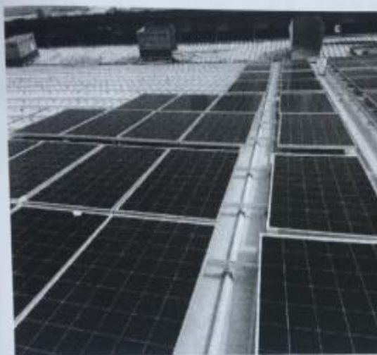
31#组件摆放屋面，长时间不安装
