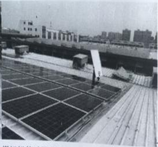
搬运组件时用背接触组件玻璃面
