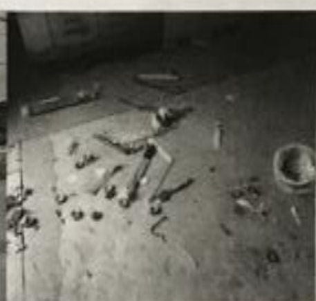
配电室施工垃圾未及时清理
