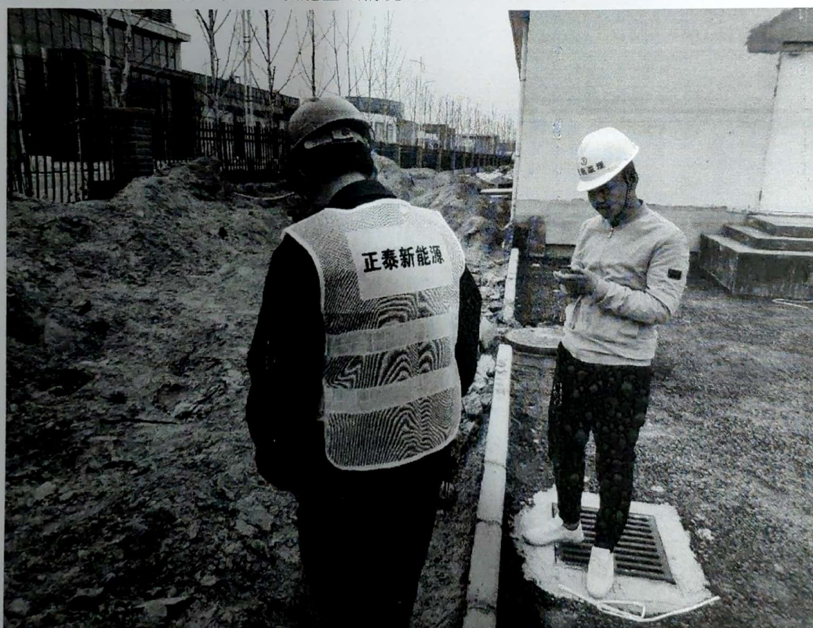
喜临门项目现场查看一次、二次舱基础情况 02
