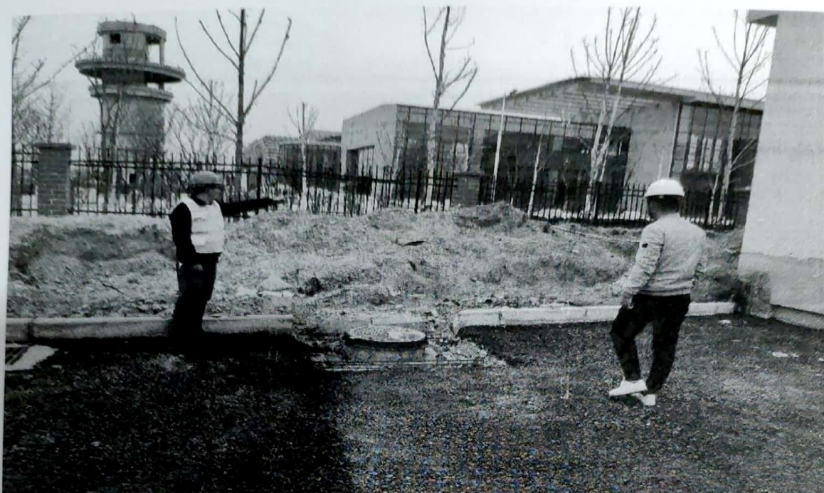
喜临门项目现场查看一次、二次舱基础情况 01
