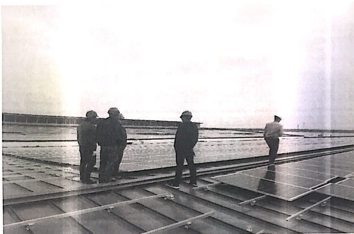
业主方、施工方、监理方三方共同检查喜临门 7#厂房屋面光伏组件安装情况（一）
