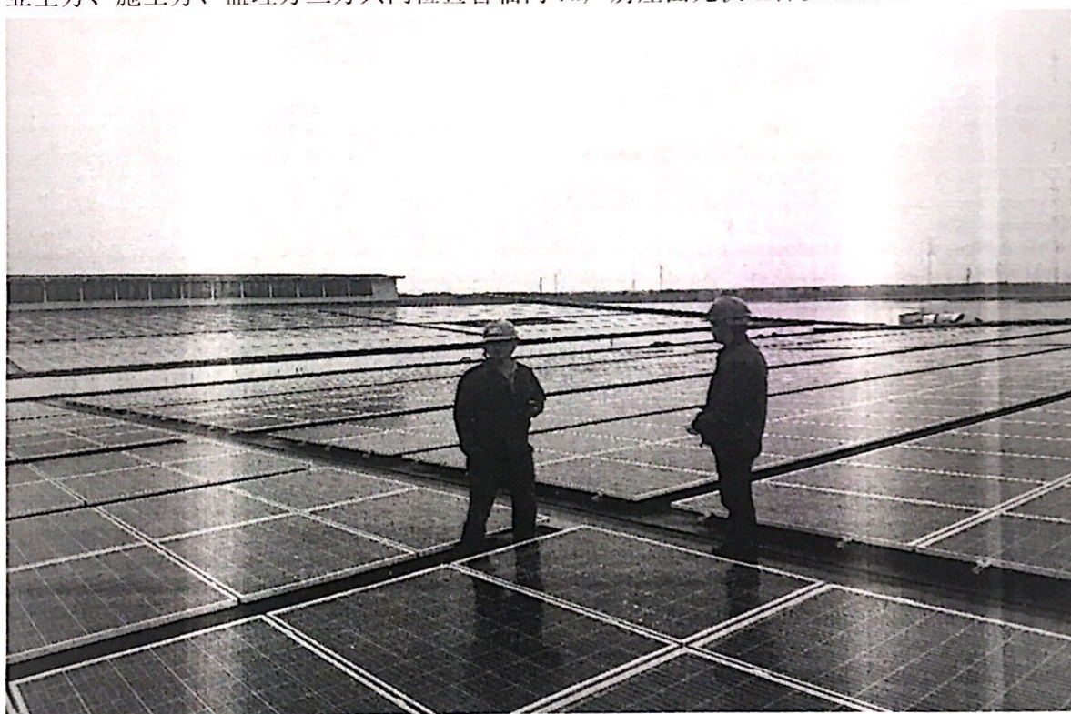
业主方、施工方、监理方三方共同检查喜临门 7#厂房屋面光伏组件安装情况（二）
