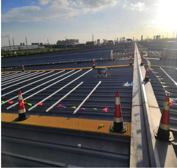
屋面施工区域安全防护齐全
