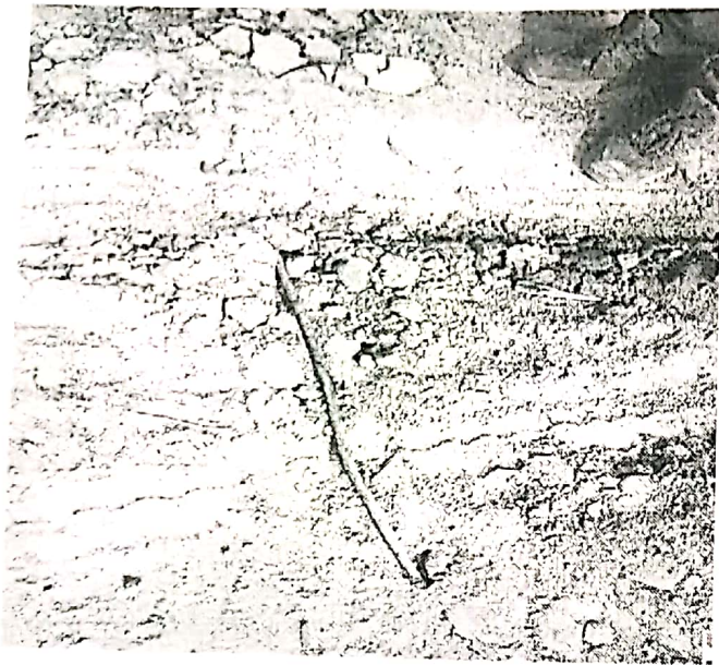
施工现场临时用电未做防护措施
