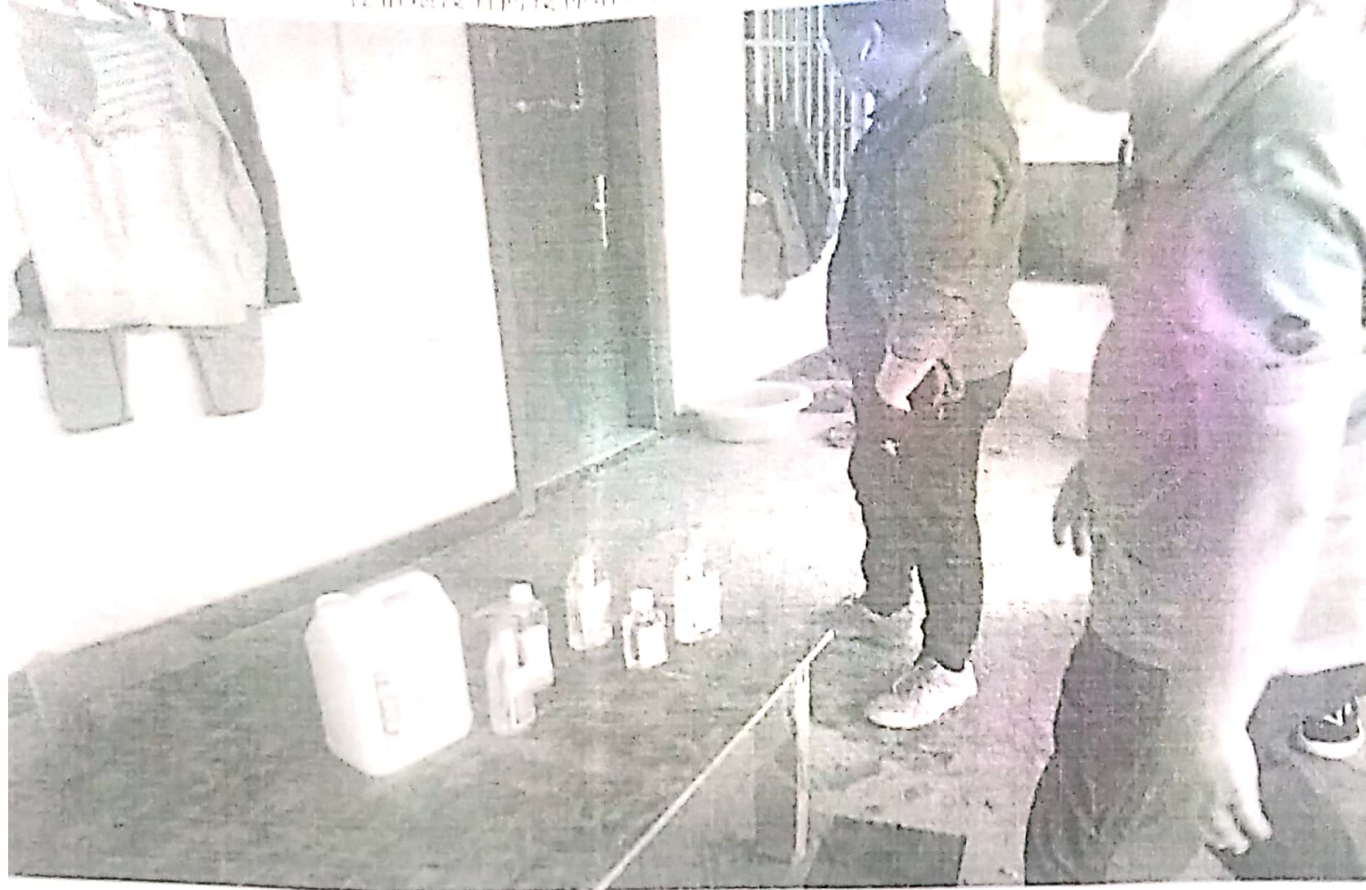
现场施工人员未佩戴安全帽
