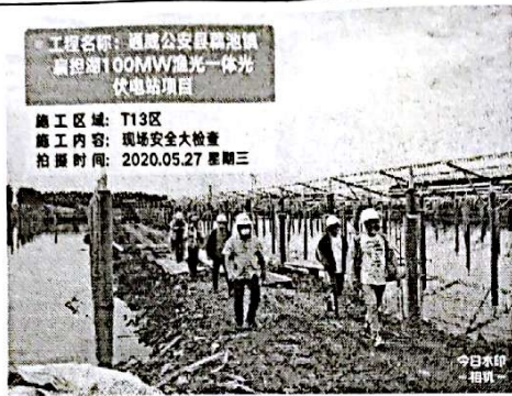
T13 区现场检查
