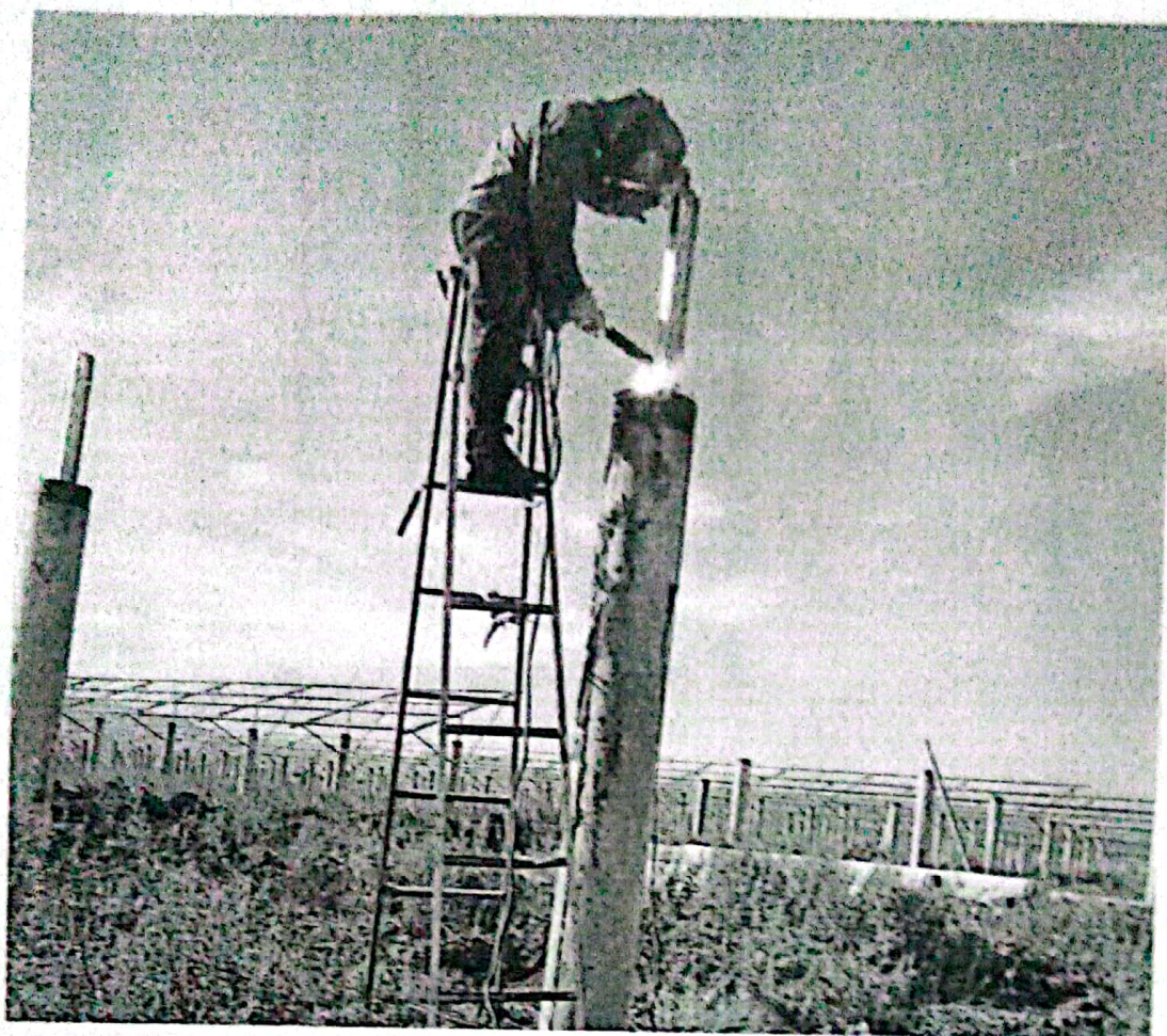
施工现场照片
